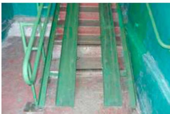
В большинстве подъездов построенных жилых зданий нет возможностей установить пандус, соответствующий установленным нормам. К тому же лестничные пролёты бывают крайне узки и не позволяют построить стационарный пандус даже ненормативного уклона.
