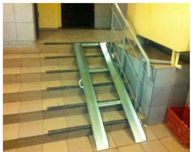
помещениях с небольшими перепадами уровней. Они изготавливаются в складных и нескладных вариантах, как правило, из алюминия, для того, чтобы их можно было переносить. Максимальный угол наклона, при котором допустимо пользоваться такими пандусами – 15%. Такой вариант безопасен, только если человека на коляске сопровождают и страхуют.
