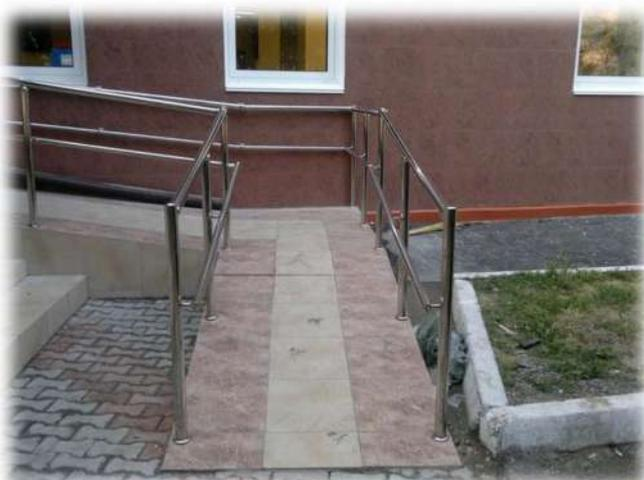
Одна из самых распространенных ошибок при проектировании пандуса заключается в том, что архитекторы либо забывают предусмотреть горизонтальную площадку у основания пандуса, либо ее размеров недостаточно, чтобы на инвалидной коляске подъехать к наклонной части.
