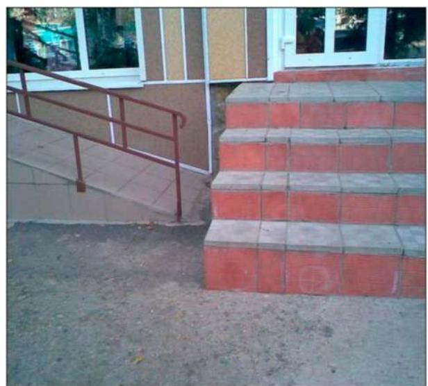
На фотографии продемонстрирован пандус, пользование которым инвалидами опасно для их жизни. Прежде всего, это отсутствие с одной стороны ограждения и поручня, также ненормативный уклон, отсутствие в середине пролёта площадки для отдыха и не сплошное покрытие поверхности пандуса. Подняться по такому пандусу инвалид на коляске просто не сможет, а если попытается спуститься, то это гарантированно травмами.
