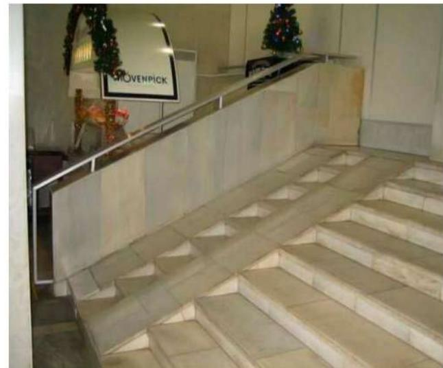
В большинстве подъездов построенных жилых зданий нет возможностей установить пандус, соответствующий установленным нормам. К тому же лестничные пролёты бывают крайне узки и не позволяют построить стационарный пандус даже ненормативного уклона.
