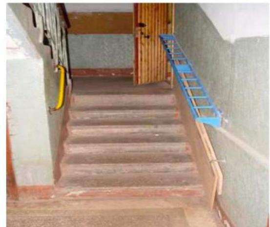
Также возможна установка откидного пандуса из швеллеров. Но при этом очень важно учитывать вес создаваемой конструкции, так как его вам часто придётся откидывать и складывать к стене. Поэтому оптимально делать их из алюминиевых сплавов, а также один из швеллеров лучше сделать стационарным.
