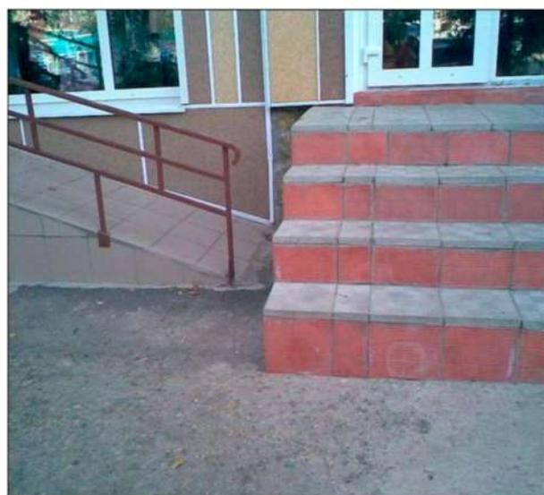
На фотографии продемонстрирован пандус, пользование которым инвалидами опасно для их жизни. Прежде всего, это отсутствие с одной стороны ограждения и поручня, также ненормативный уклон, отсутствие в середине пролёта площадки для отдыха и не сплошное полотно покрытия поверхности пандуса. Подняться по такому пандусу инвалид на коляске просто не сможет, а если попытается спуститься, то это гарантированно травмами.
