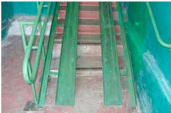
В этих случаях возможна установка откидных ненормативных пандусов. На фотографии продемонстрирован сплошной откидной деревянный пандус, который в обычное время крепится к стене.
