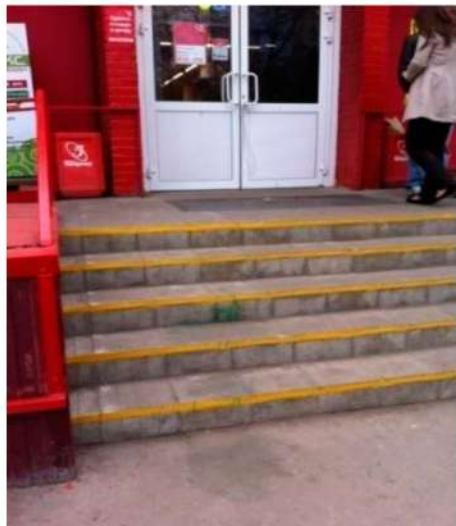
СП 59.13330 п. 5.2.31 Возможно применение для ориентации и помощи слепым и слабовидящим защитного углового профиля на каждой ступени по ширине марша. Материал должен быть шириной 0,05 - 0,065 м на приступи и 0,03 - 0,055 м на подступенке. Он должен визуально контрастировать с остальной поверхностью ступени
