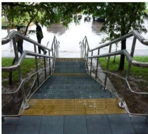
Рекомендовать выполнить контрастную маркировку ступеней, в том числе установку противоскользящих покрытий по краю ступени. При отсутствии маркировки – доступность для слепых
