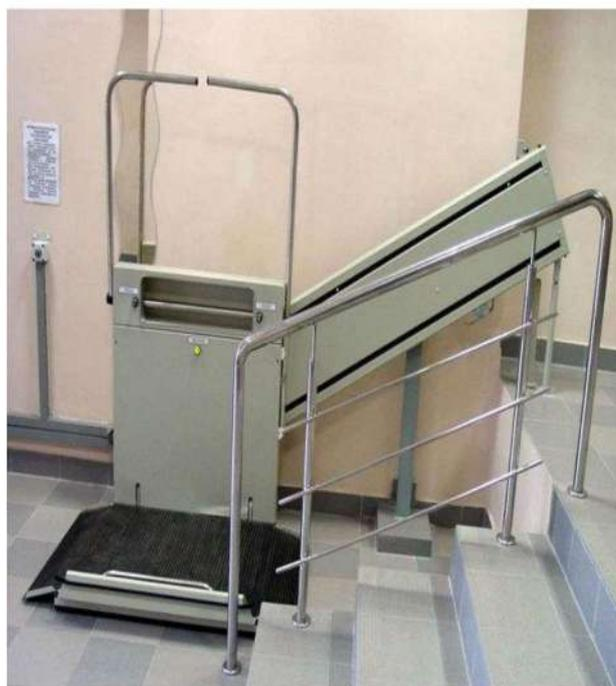
Подъемники могут использоваться как внутри, так и снаружи зданий. При необходимости он может оснащаться шлагбаумом или шахтой с дверями. При разнице отметок до 1,8 м обычно используются открытые платформы. Подъемники с закрытыми кабинами внешне напоминают обычные лифты.
